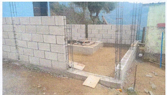
Foto 2: AVANCE DE LA COCINA
