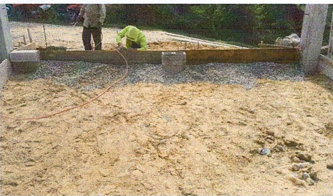
Foto 3: AVANCE DE PATIO
