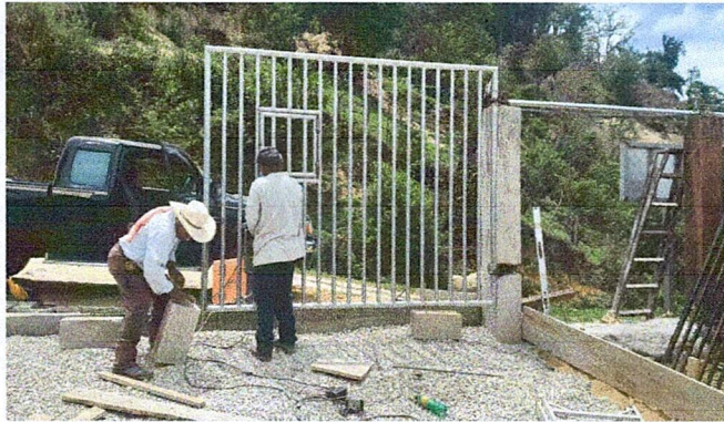
Foto 1: AVANCE DEL PORTÓN
