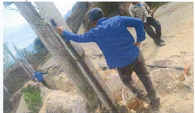
Foto 4: AVANCE DE CERCO PERIMETRAL
